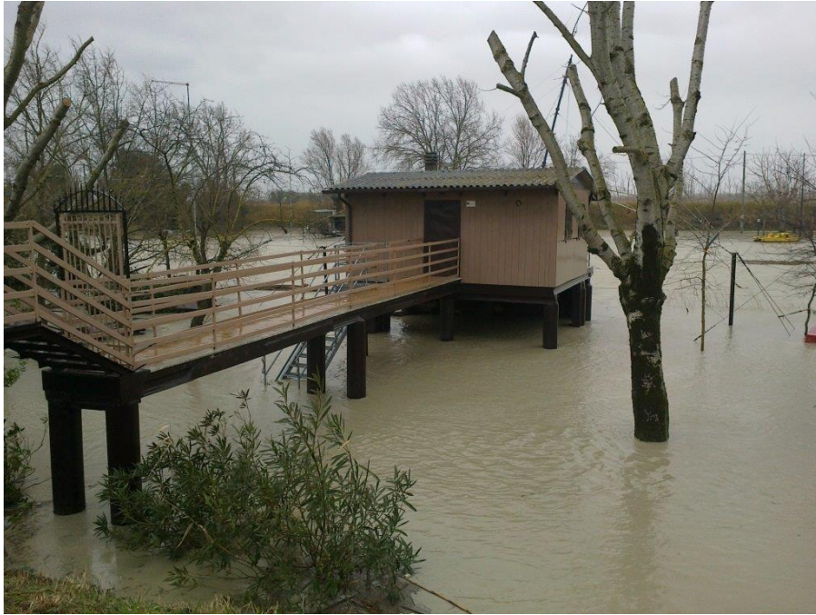
Figura 47 - Esempio di capanno fondato su pali, presente in alveo nel tratto terminale dei fiumi Uniti; la foto è stata ripresa in occasione della piena del settembre 2014.
